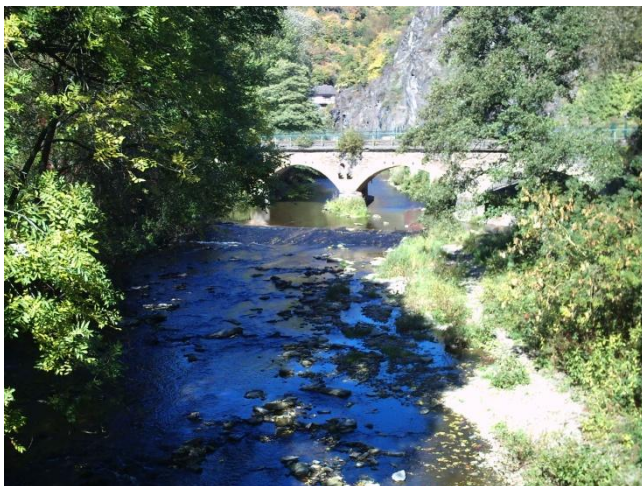
Viadukt über die Ahr bei Dernau
